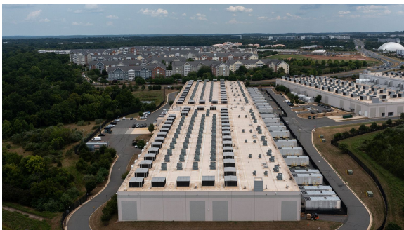
Centre de données d'Amazon Web Services à Ashburn, Virginie, USA
